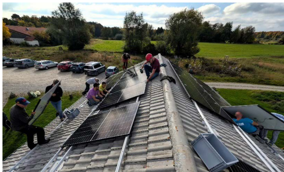
Verlegung der PV-Module
